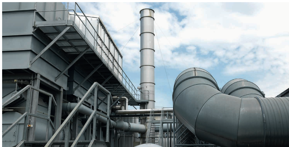
Die Abluftreinigungsanlage auf dem Dach der Wipf AG ist das Herzstück zur Steigerung der Energieeffizienz.
